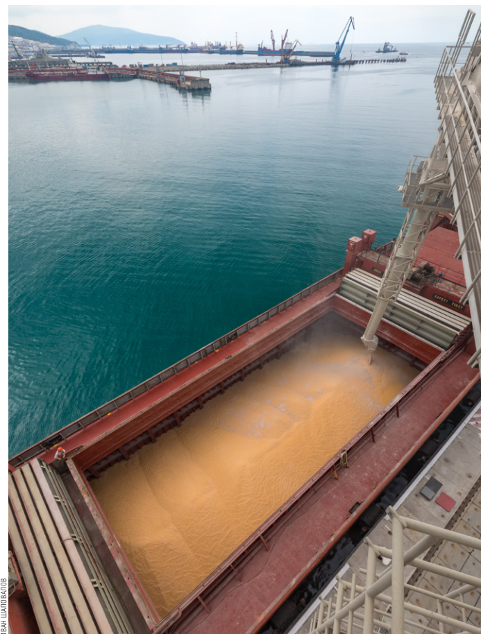
ИНВЕСТИЦИОННАЯ ПРОГРАММА РАЗВИТИЯ ЗЕРНОВОГО ТЕРМИНАЛА КСК ПРЕДПОЛАГАЕТ СТРОИТЕЛЬСТВО ВТОРОГО ПРИЧАЛА И НОВЫХ СИЛОСНЫХ ХРАНИЛИЩ НА 110 ТЫС. ТОНН
