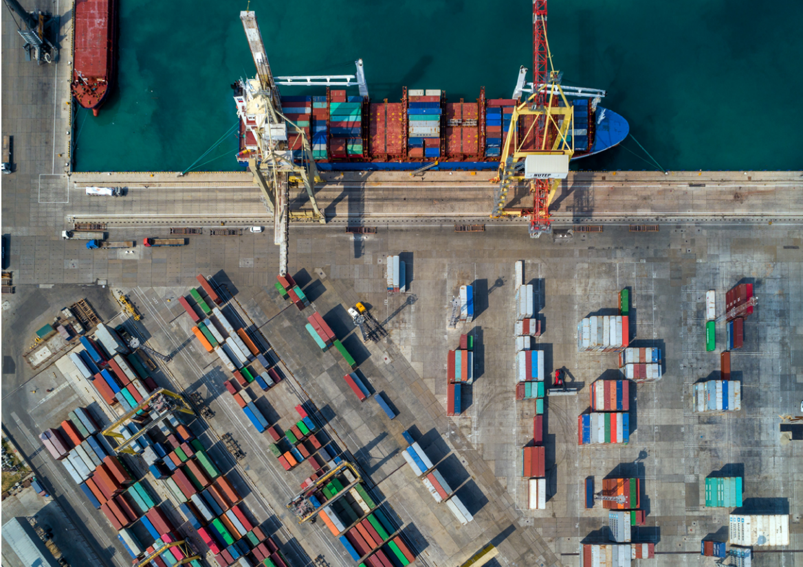
НЕСМОТЯ НА СТРОИТЕЛЬНЫЕ РАБОТЫ НА СОСЕДНЕМ ПРИЧАЛЕ, СТИВИДОРЫ НУТЭП УМУДРЯЮТСЯ ДОСТИГАТЬ РЕКОРДНЫХ ПОКАЗАТЕЛЕЙ ПЕРЕВАЛКИ КОНТЕЙНЕРОВ
